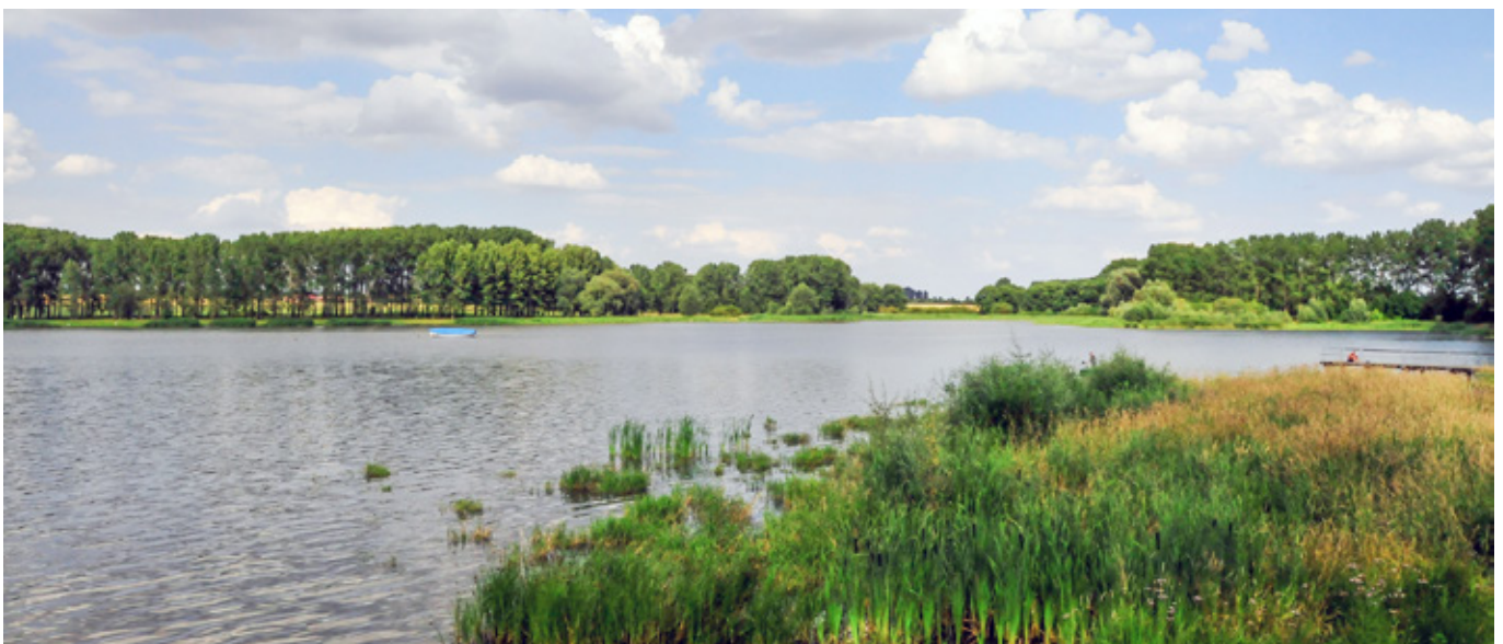
Die überstaute Fläche am Immertalstausee wurde in das Eigentum der Thüringer Fernwasserversorgung überführt
