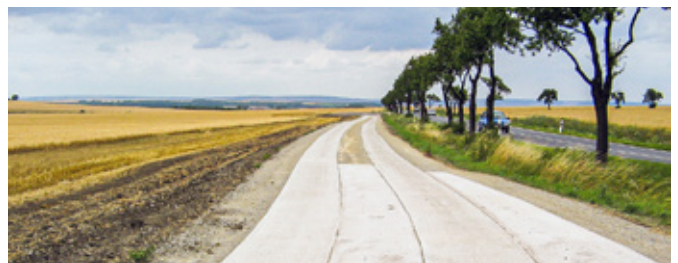
Im Verfahren hergestellter Betonspurbahnweg Richtung Sömmerda
