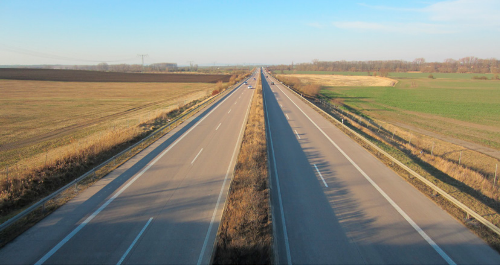
Die neugebaute A 71 im Bereich des Flurbereinigungsverfahrens Schloßvippach
