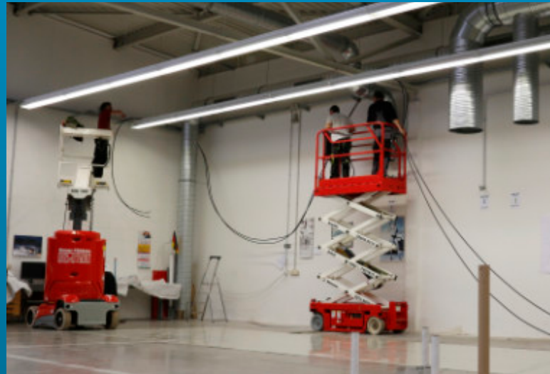
07. Dezember 2020: Verlegen der neuen Anschlussleitungen mittels Hubarbeitsbühnen
