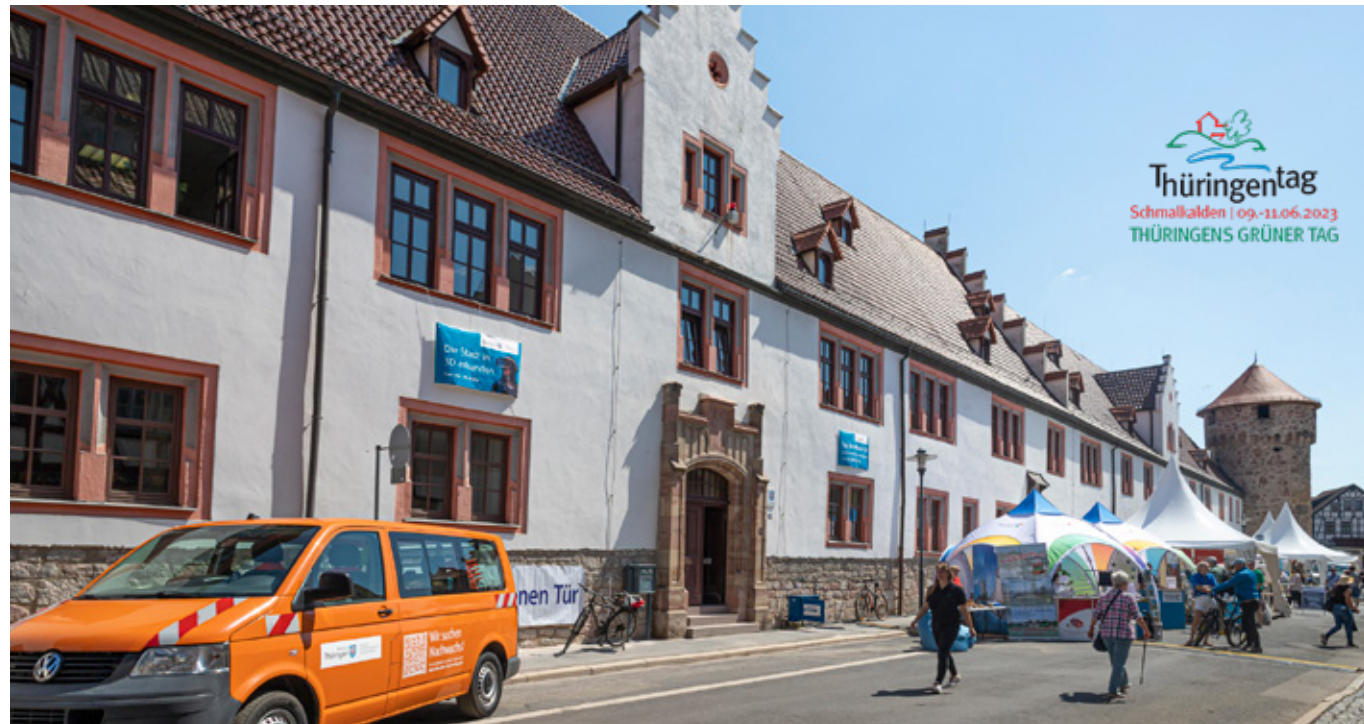
„Eines der schönsten Amtsgebäude in Thüringen“ – Katasterbereichsleiter Olaf Krech über unseren Standort an der Hoffnung 30
