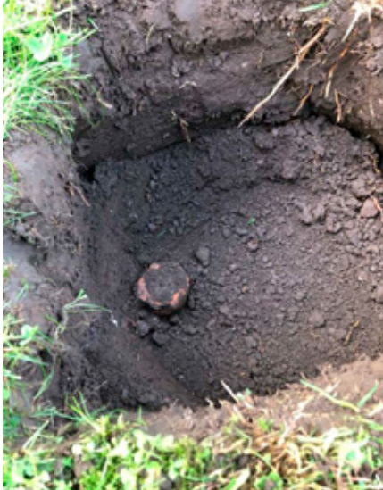
Vorgefundenes Drainrohr
