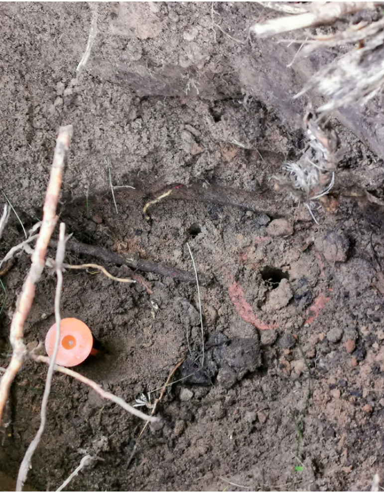
▲ Abb. 3: Vergleich von „Absteckkoordinate“ (Möhre) und vorgefundenem Drainrohr
