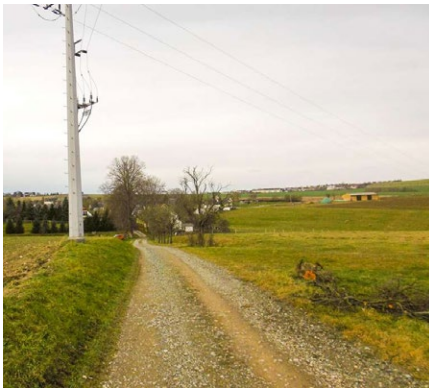
▲ Weg nach Neugernsdorf vor dem Ausbau
