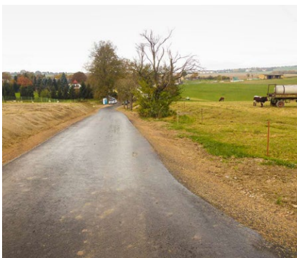
▲ Weg nach Neugernsdorf zur Bauabnahme
