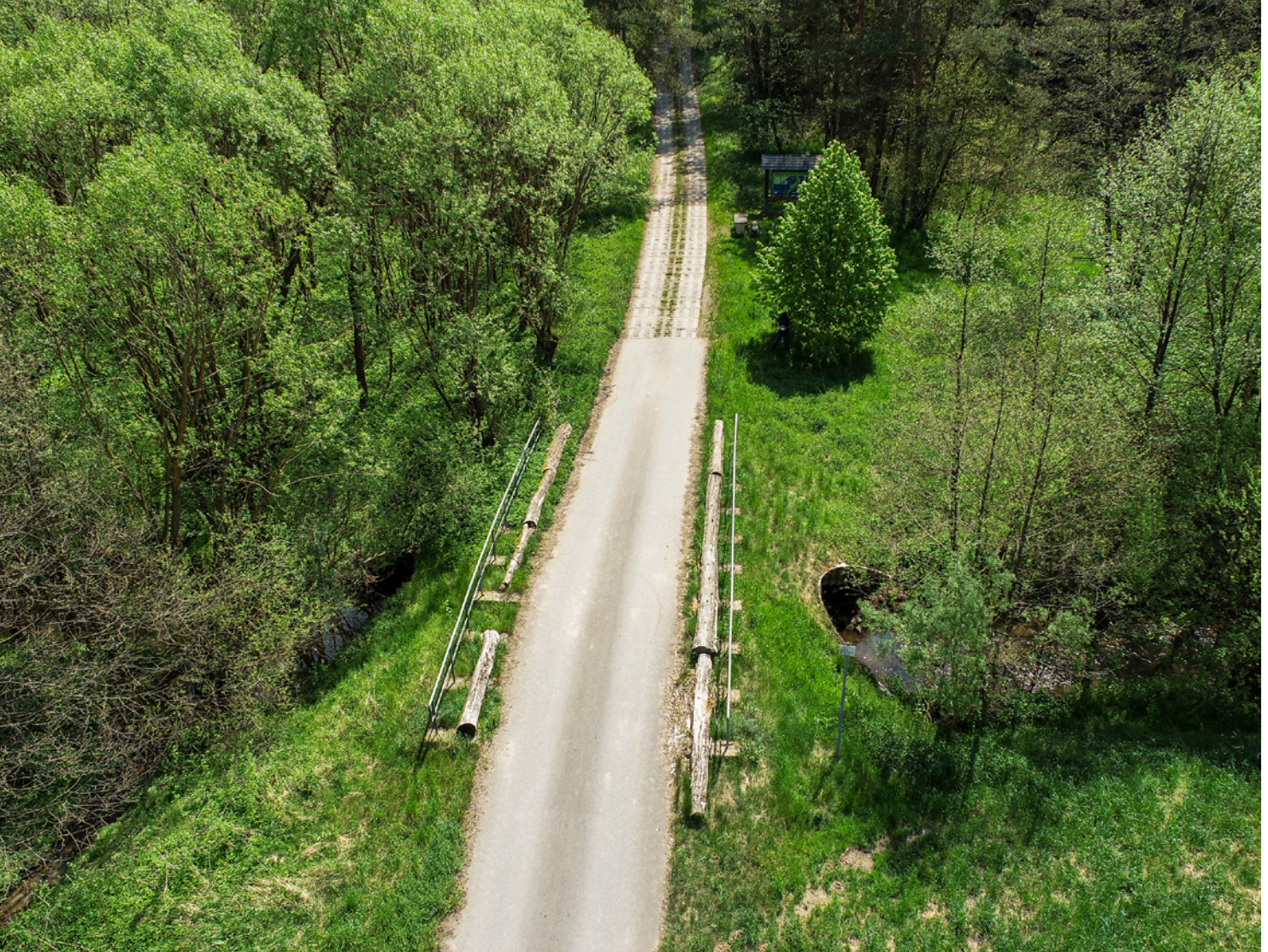
▲ Drohnenaufnahme der Gewölbebrücke, nordöstlich des Überschwemmungsgebietes
