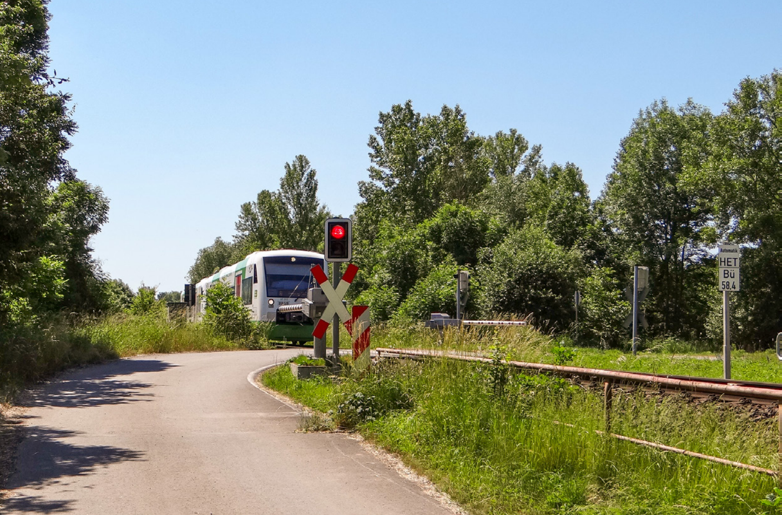
▲ Wegebau zum Bahnübergang Bahnstrecke Gera–Leipzig
