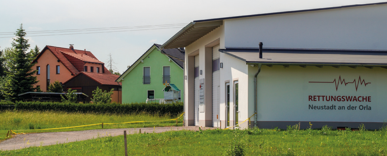
▲ Neue Wohnansiedlung und Neubau Rettungswache im Gewerbegebiet
