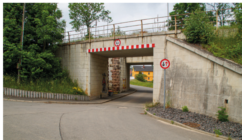
▲ Ausbau der Brückenunterführung Bahnstrecke Gera–Saalfeld
