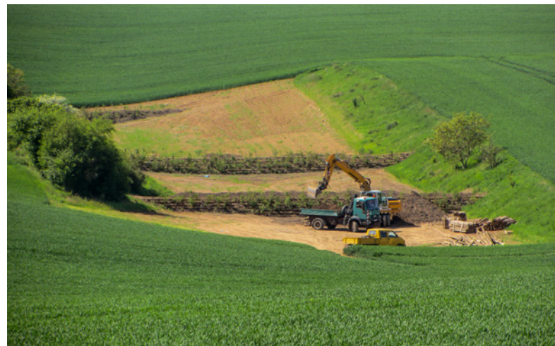
▲ Umgesetzte „Lebende Sperre“ (Krainerwand)
