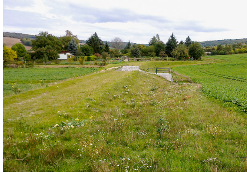
▲ Regenrückhaltebecken nördlich (10.000 m³ Retentionsraum) und südlich (2.000 m³ Retentionsraum) der Ortslage ▲
