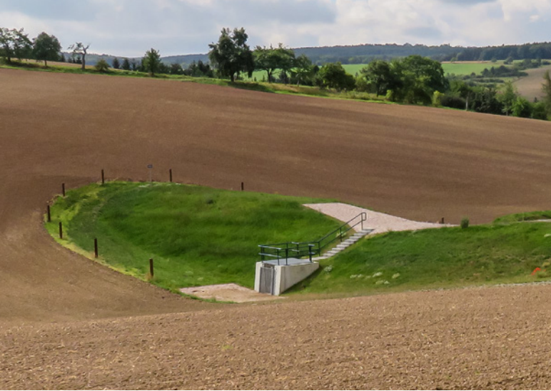
▲ Regenrückhaltebecken nördlich (10.000 m³ Retentionsraum) und südlich (2.000 m³ Retentionsraum) der Ortslage ▲
