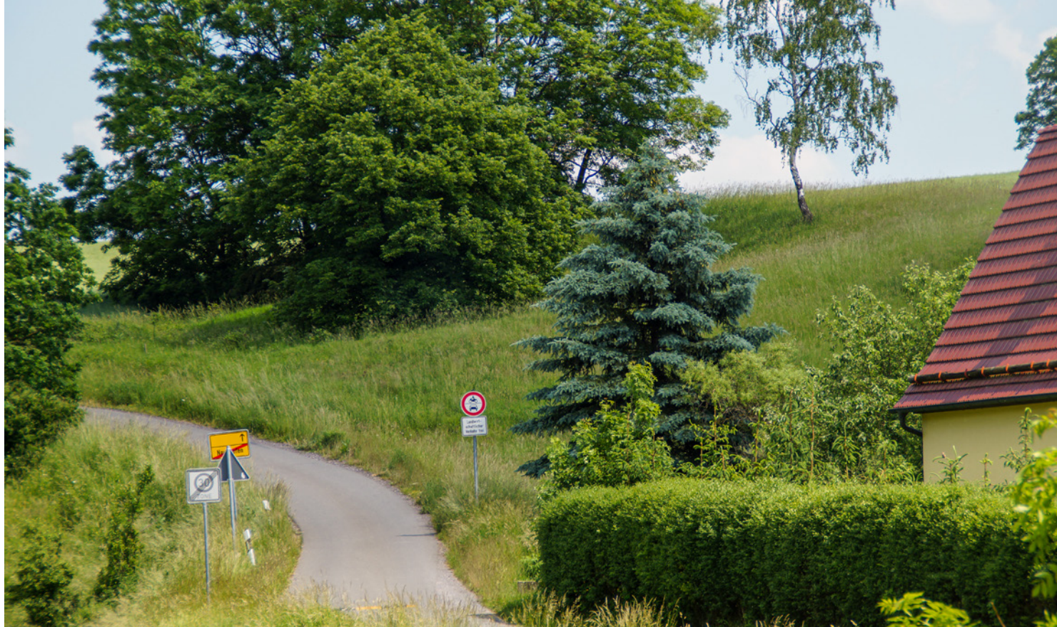
▲ Neubau ländlicher Weg in die Feldlage
